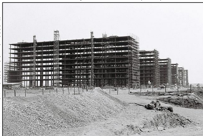
CONSTRUÇÃO DE BRASÍLIA (1960)
